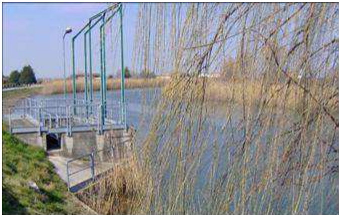
Foto n. 2: Opera di presa a Torre Caligo
