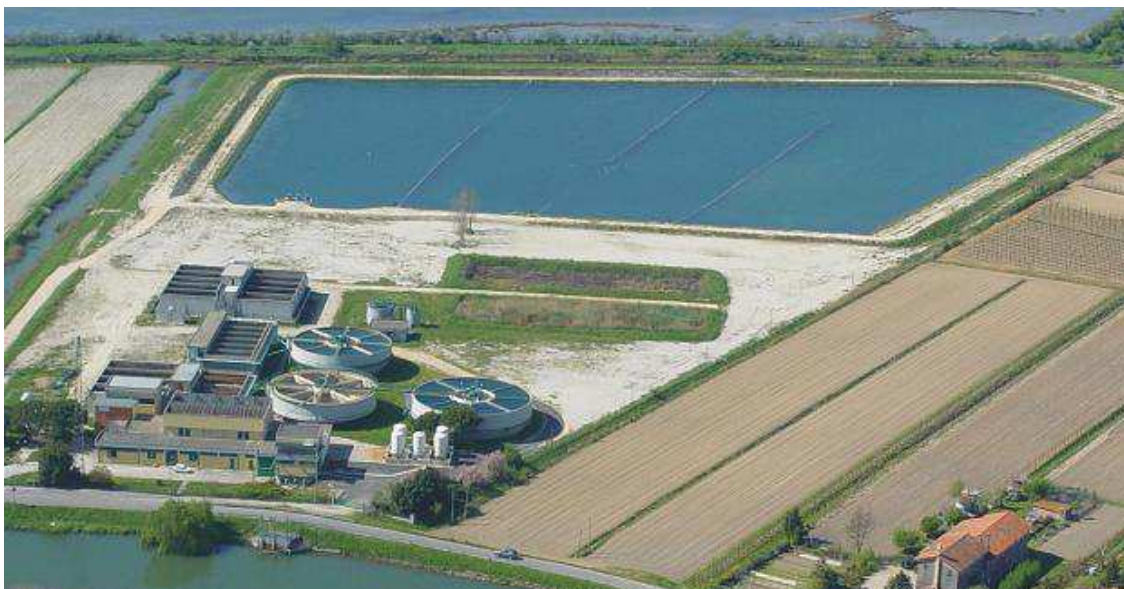
Foto n. 1: Visuale d'insieme dell'impianto di potabilizzazione di Torre Caligo
